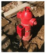
3.2.8 将航空插头接入消火栓传感器并旋紧到位,等待 30 秒后打开消火栓上端开关放几十秒水后关断,等待 2 分钟后查看平台数据,若水压,叶轮转速均无误,即恢复现场,完成施工。
